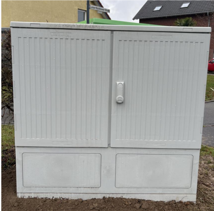
Glasfaserverteiler
