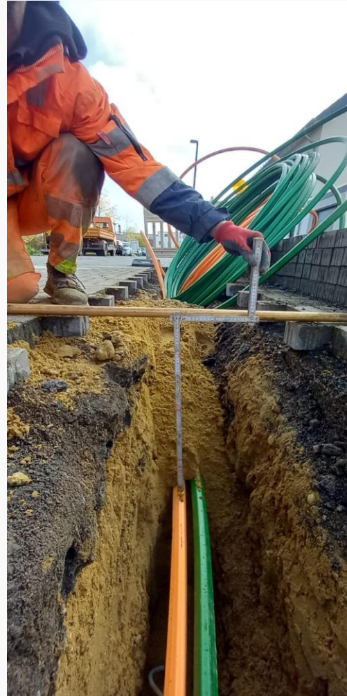
Offene Bauweise im Pflaster
