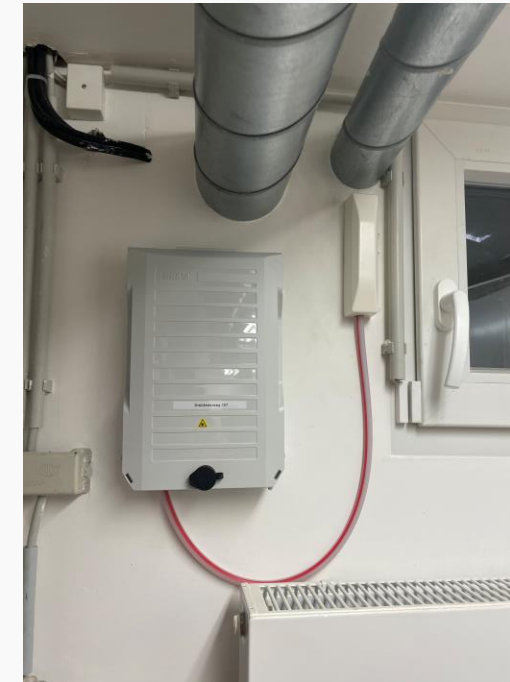
Hausanschlusskasten / fertiger Glasfaserhausanschluss
