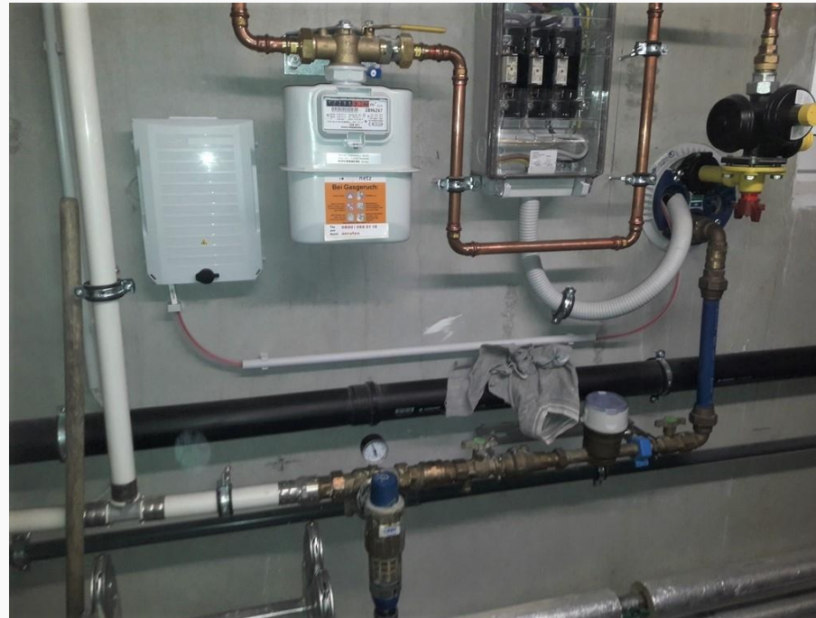
Hausanschlusskasten / fertiger Glasfaserhausanschluss
