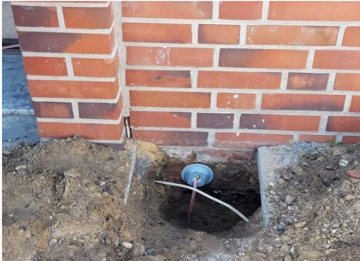
Kopfloch Hausanschluss für Hauseinführung
